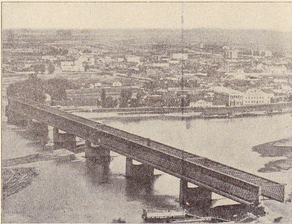
Pont sur le Dnjepr.
